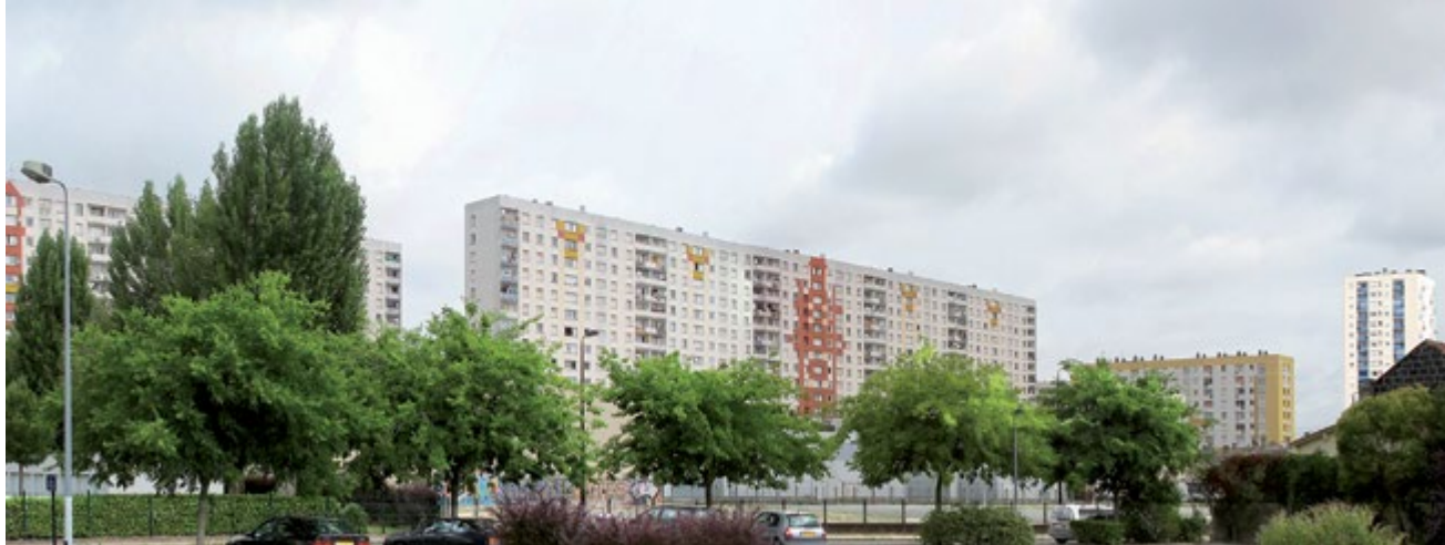
Anne Lacaton & Jean-Philippe Vassal, Frédéric Druot, Christophe Hutin, Transformation de 530 logements, bâtiments G, H, I, quartier du Grand Parc , 2017. © Lacaton & Vassal - Druot - Hutin.
